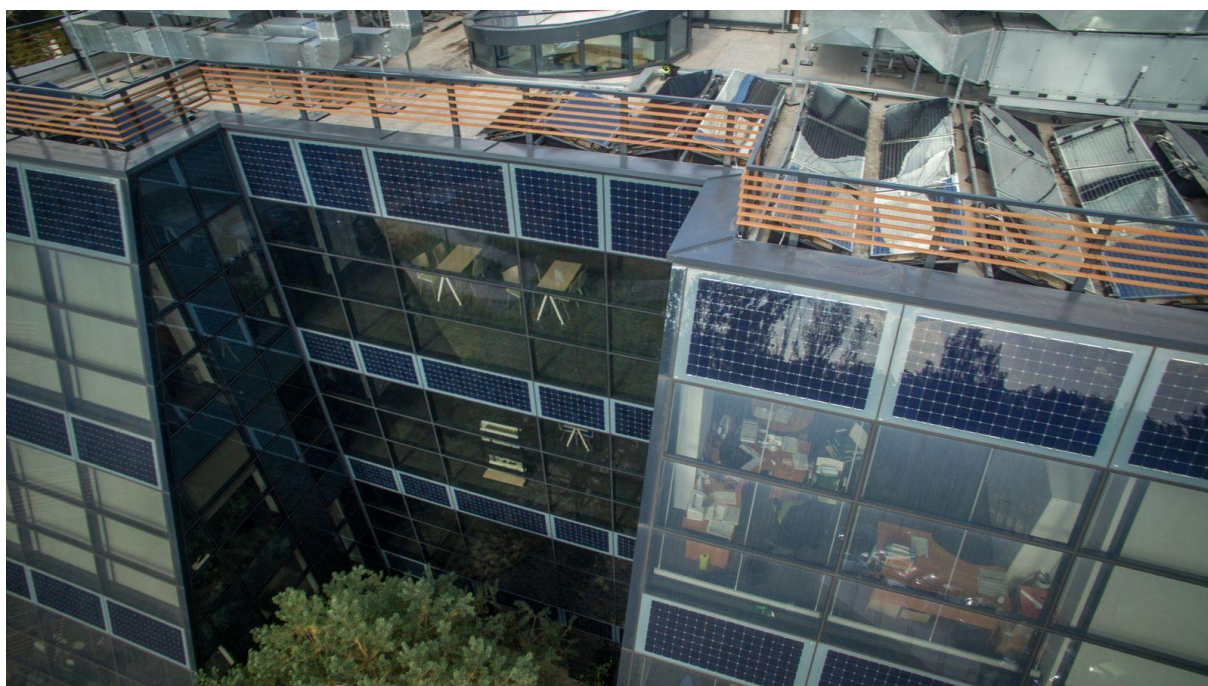
Fot. 4. Panele fotowoltaiczne na elewacji i dachu siedziby WFOŚiGW w Łodzi.
