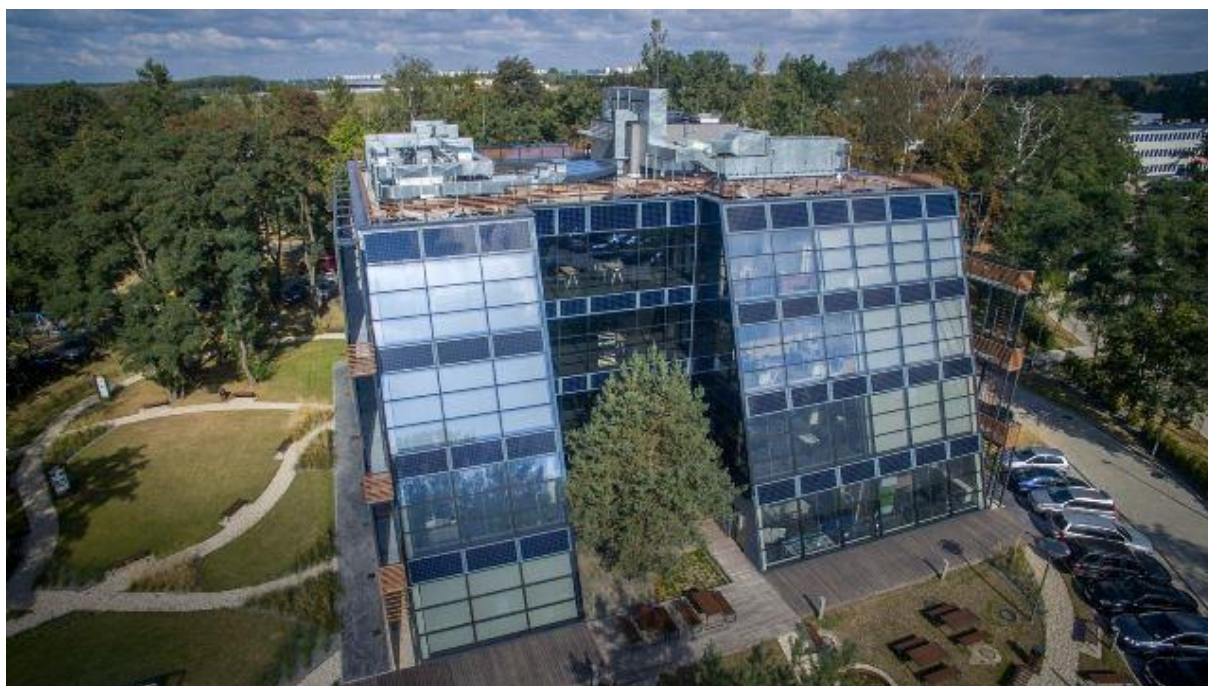
Fot. 5. Elewacja południowa budynku WFOŚiGW w Łodzi.
